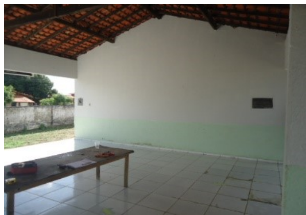
FOTO 04: REFORMA DA U.E. IDELFONSO JOSÉ DE ARAÚJO
