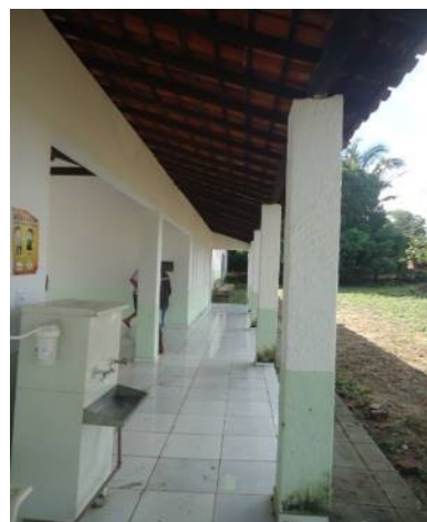
FOTO 06: REFORMA DA U.E. IDELFONSO JOSÉ DE ARAÚJO
