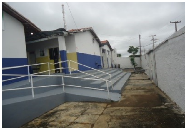
FOTO 02: REFORMA DA U.E. SANTO ANTÔNIO
