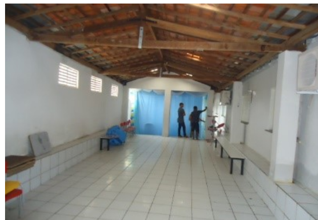
FOTO 06: REFORMA DA U.E. SANTO ANTÔNIO
