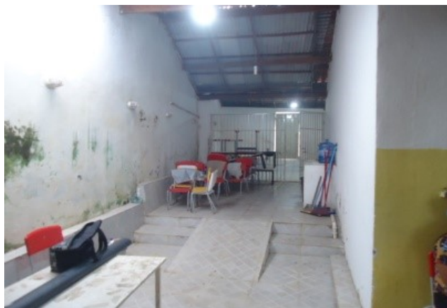
FOTO 05: REFORMA DA U.E. SANTO ANTÔNIO
