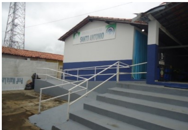
FOTO 01: REFORMA DA U.E. SANTO ANTÔNIO
