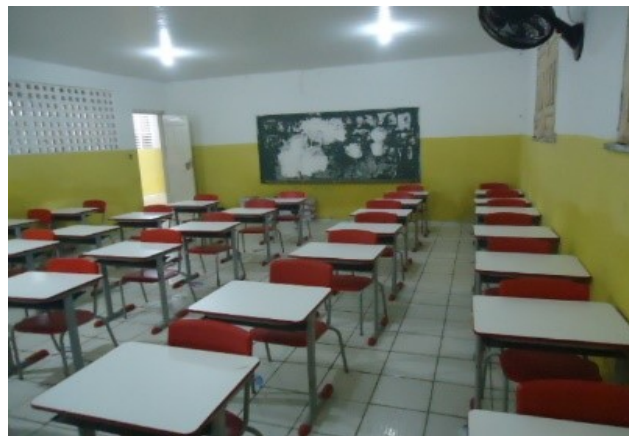
FOTO 04: REFORMA DA U.E. SANTO ANTÔNIO
