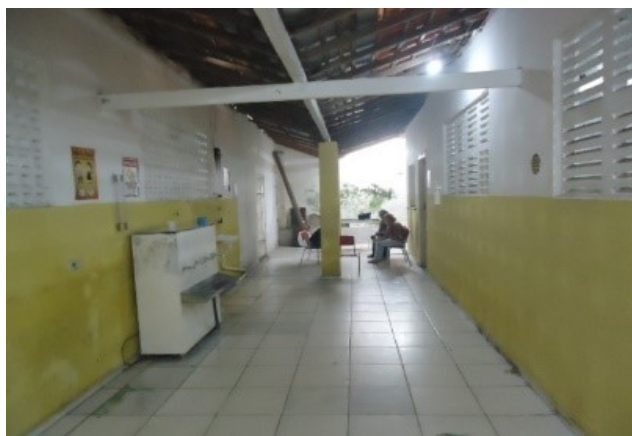
FOTO 03: REFORMA DA U.E. SANTO ANTÔNIO
