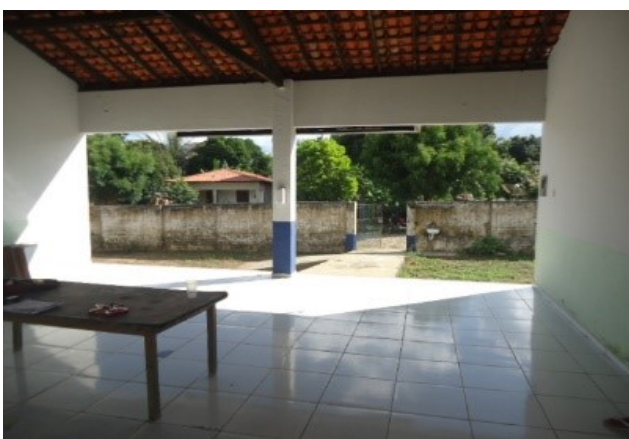
FOTO 03: REFORMA DA U.E. IDELFONSO JOSÉ DE ARAÚJO
