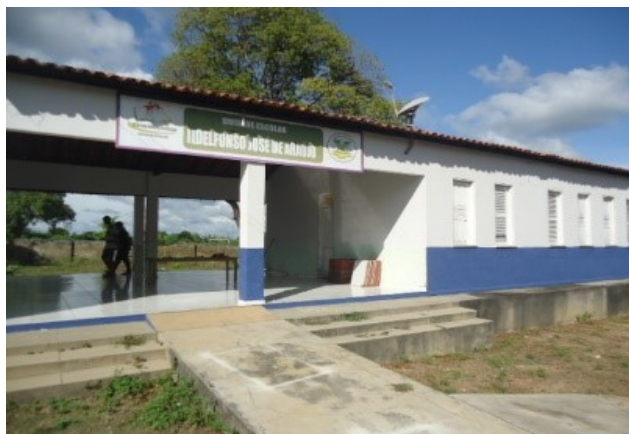
FOTO 01: REFORMA DA U.E. IDELFONSO JOSÉ DE ARAÚJO
