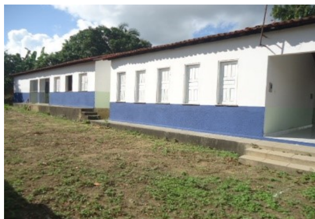
FOTO 02: REFORMA DA U.E. IDELFONSO JOSÉ DE ARAÚJO
