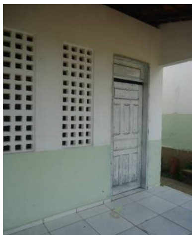
FOTO 05: REFORMA DA U.E. IDELFONSO JOSÉ DE ARAÚJO
